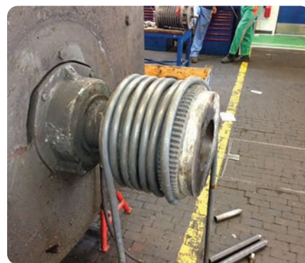
Verwarming van een koppeling voor demontage
